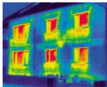
Die Wärmebilder zeigen die kritischen Stellen
